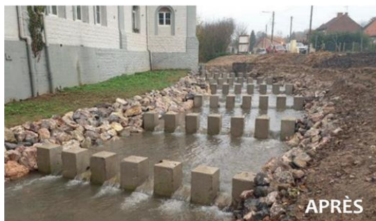
Travaux de mise en place d'une passe à poissons ©CU d'Arras
