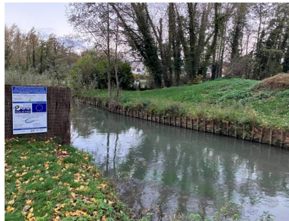
Protection de berge en fascine vivante à Arras ©CU d'Arras
