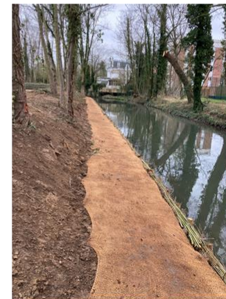
Protection de berge en fascine à Ste Catherine ©CU d'Arras
