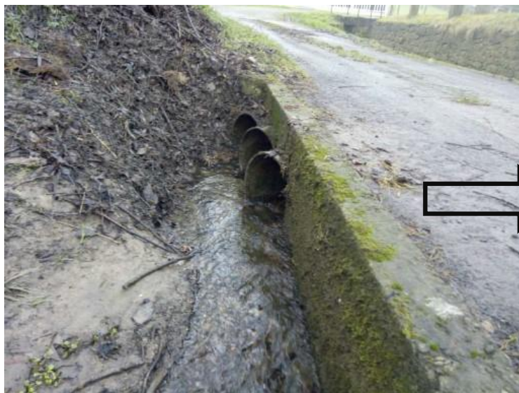
Etat de l'ouvrage avant intervention
