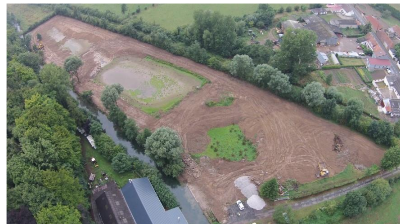
Vue aérienne du site de Ouve-Wirquin en phase travaux (SmageAa)
