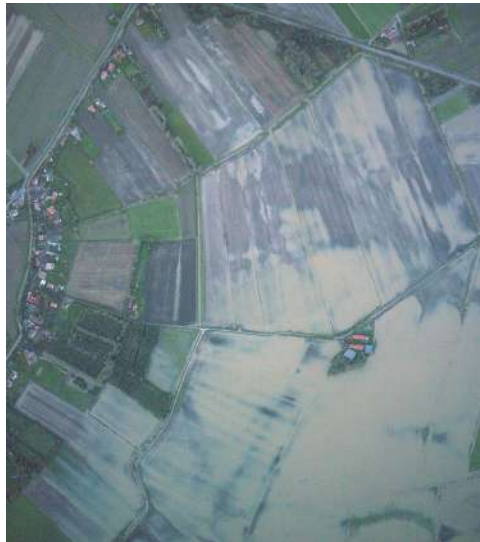
Figure 4 - Vue aérienne de la Hem à Polincove le 3 novembre 2012, après la crue (Air Marine pour le compte de la DREAL)
