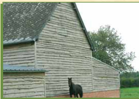
Bardage extérieur en aulne
