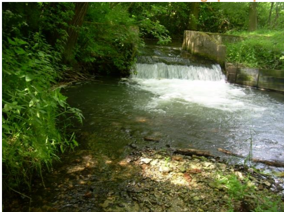
Barrage sur la Créquoise avant travaux – AEAP
