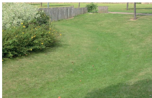
Exemple de noue à Waziers – AEAP
