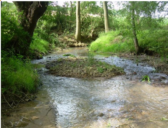
Barrage sur la Créquoise après travaux- AEAP
