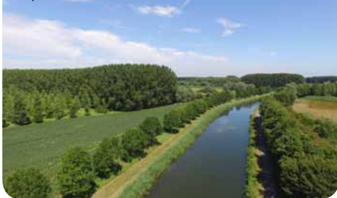
Scarpe canalisée à Vred
