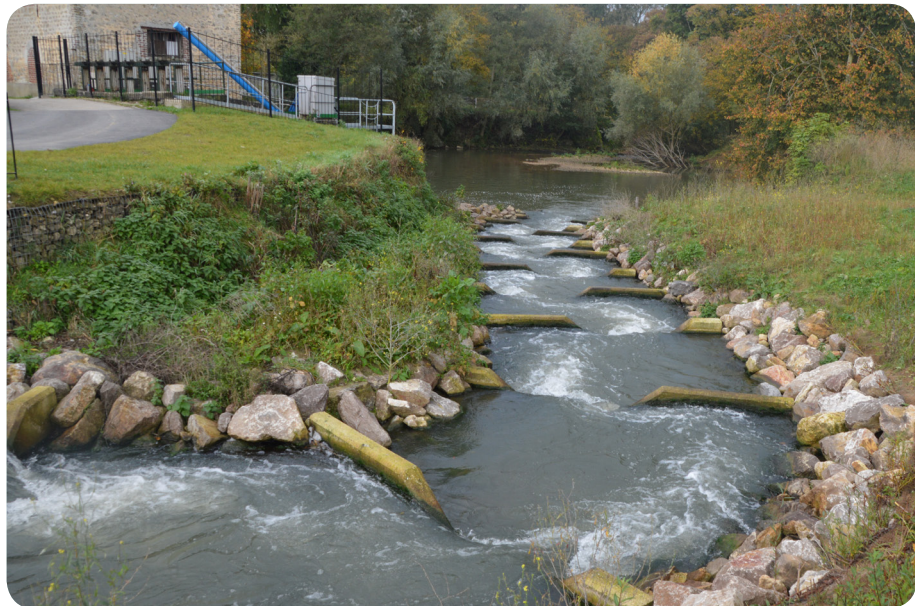
Bras de contournement avec pré-seuils à Mourlinghen (62)
