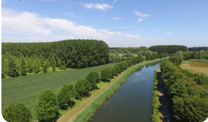
Scarpe canalisée à Vred
