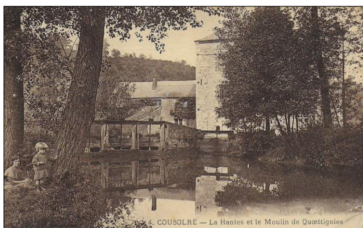
➤ Figure 19 : Vue de l'amont du moulin
