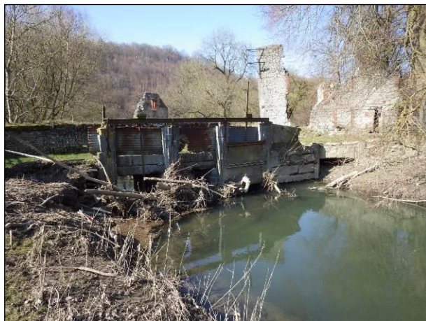
➤ Figure 43 : Vue de l'ouvrage encombré - le 17-03-17
