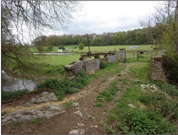
➤ Figure 25 : Vue de l'ouvrage en avril 2017
