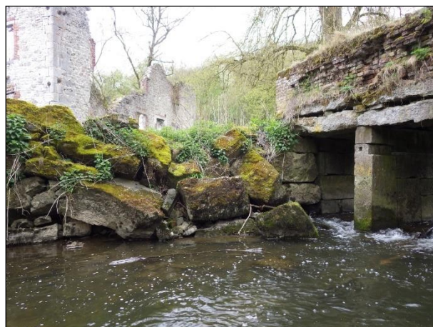
➤ Figure 73 : Vue du mur en enrochements
