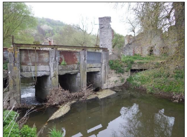
➤ Figure 44 : Vue de l'ouvrage encombré – le 15-04-17
