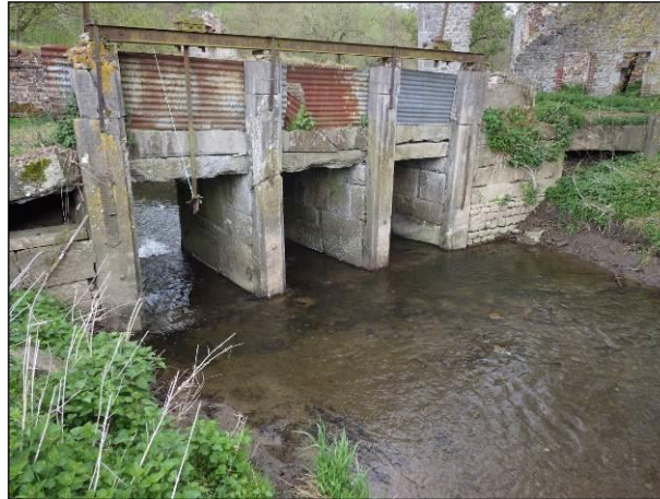
➤ Figure 26 : Vue de l'ouvrage en avril 2017
