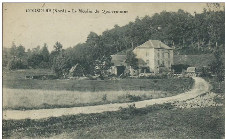
➤ Figure 17 : Vue du moulin vers 1936
